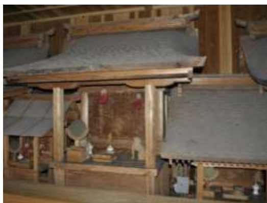
重要文化財 小川思子淵神社本殿
