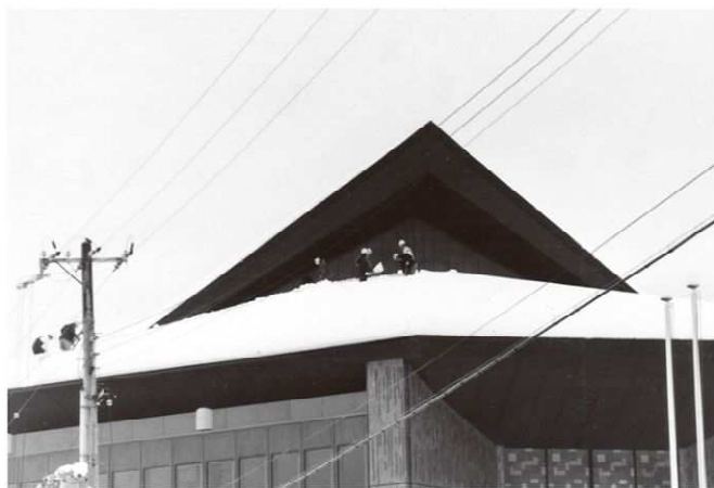
屋根で除雪作業（現：高島市民会館）
