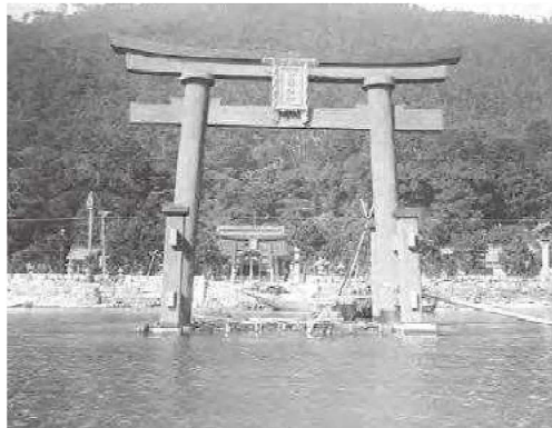
建設中の大鳥居（昭和12年）
