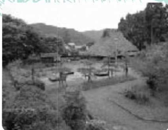
朽木陣屋跡の現在の様子
