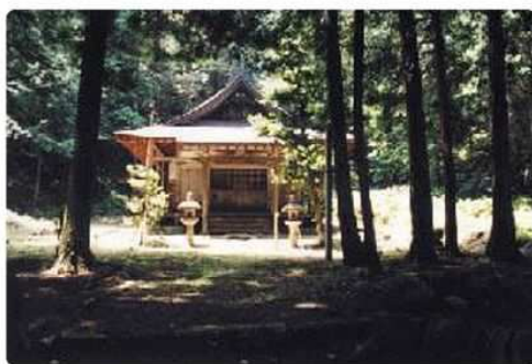
田中城跡に建つ松蓋寺観音堂
