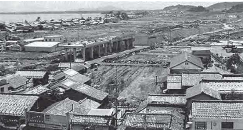
建設中の湖西線(今津町住吉付近)
