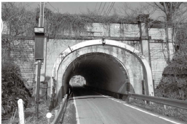
現在の百瀬川隧道
