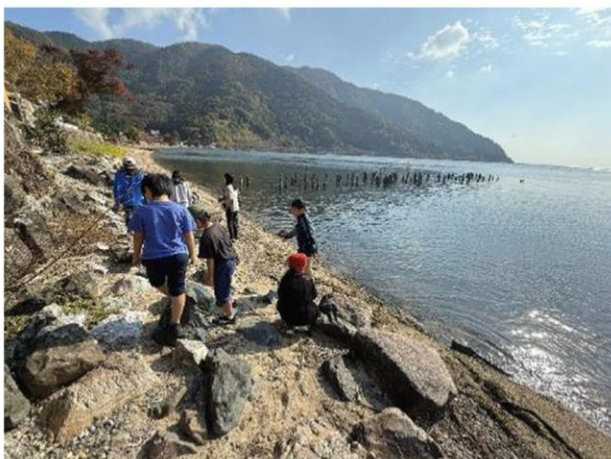
かつて石積みが崩れた場所を確認
