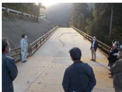
朽木地子原 道路改築工事箇所
