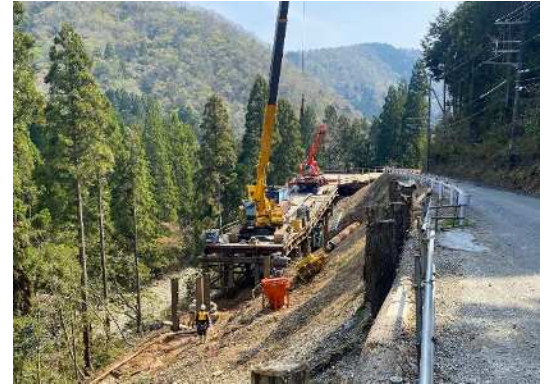
朽木地子原～雲洞谷工区 仮栈橋設置状況
