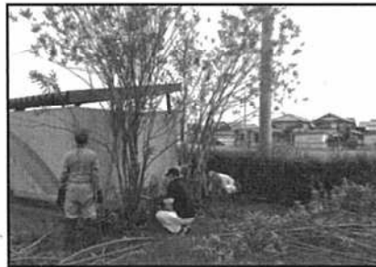
雑木伐採作業中
