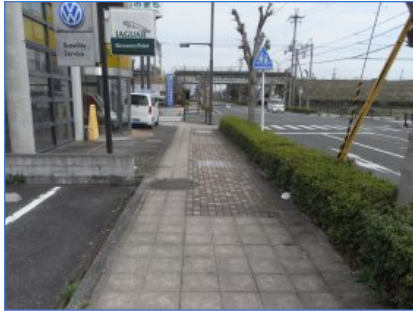
市道平井藁園 1 号線（両側歩道）
