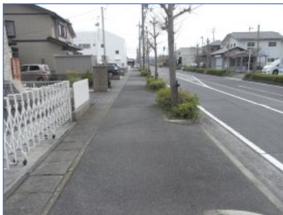
市道北畑熊野本線（両側歩道）
