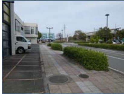
市道新旭駅西 1 号線（両側歩道）
