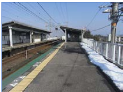
京都方面ホーム （待合室・上屋・視覚障がい者誘導用ブロック）
