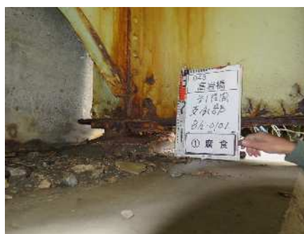
■ 鋼材の腐食
