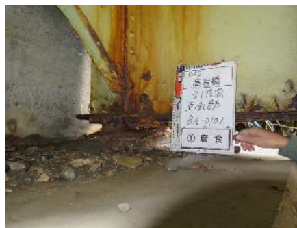
■ 鋼材の腐食
