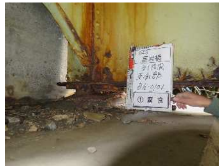
■ 鋼材の腐食
