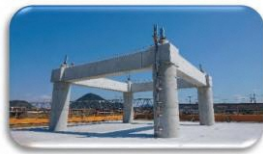
送電線鉄塔基礎工事
