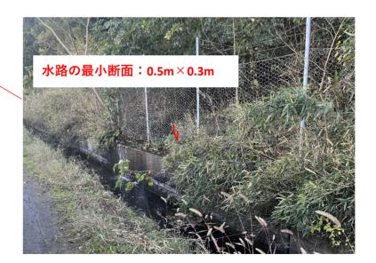
・水路の最小断面サイズ: 幅0.5m×高さ0.3m
