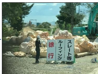
一次仮置場（熊本県益城町）
