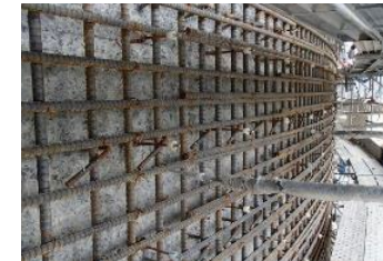
<外部遮蔽壁の補強> 2017.10~
