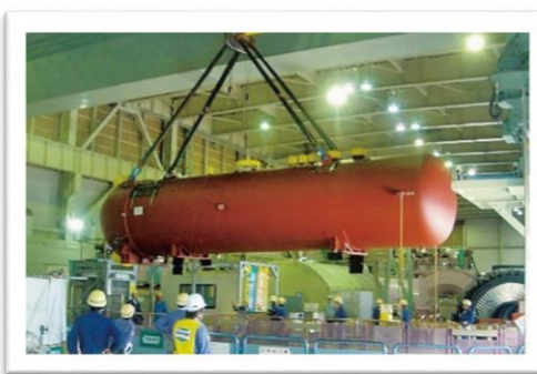
高圧給水加熱器の取替え
