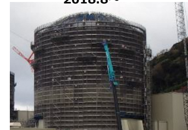
<上部鉄骨の組立> 2018.8~
