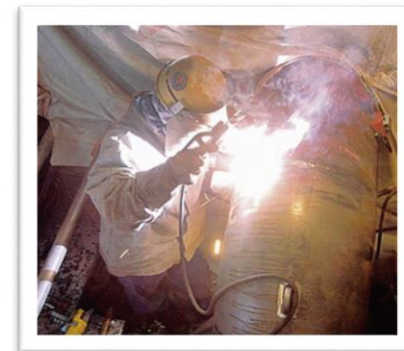
配管の取替え
