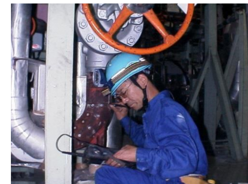
配管の厚み点検
