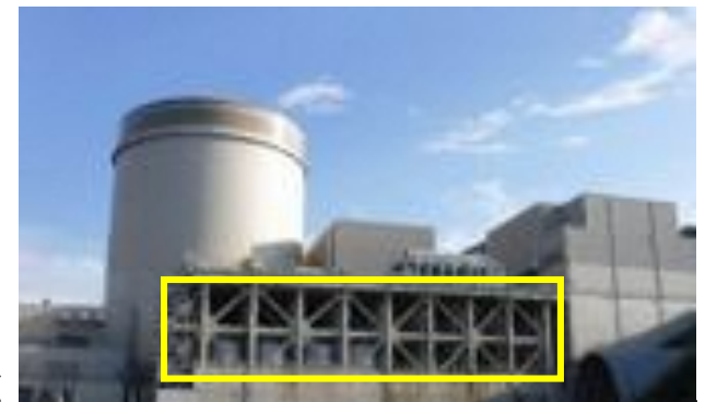
新構台の構築(現況)
