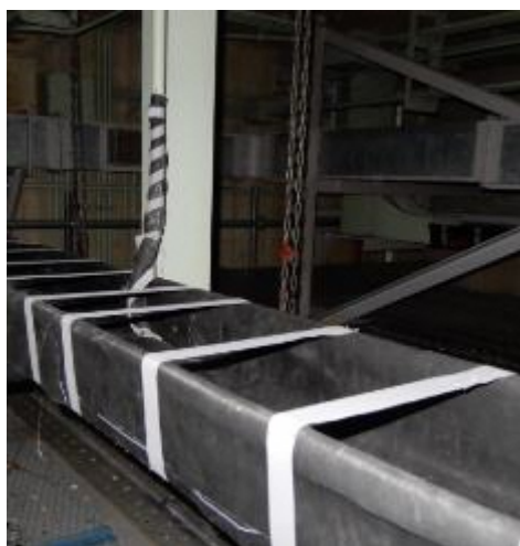
<防火シート施工箇所>
