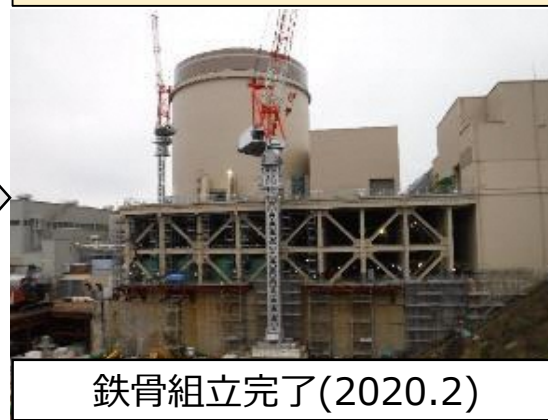
構台の設置状況
