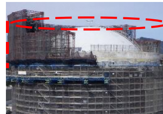
<外部遮蔽壁頂部の撤去> 2017.7~
