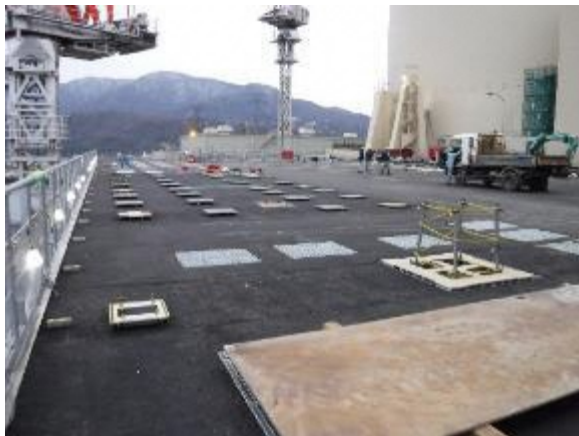
新構台の上部（現状）
