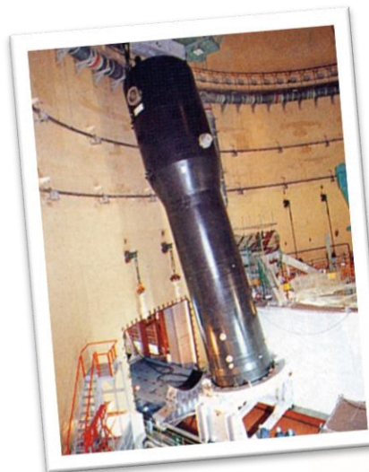
蒸気発生器の取替え
