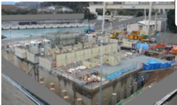
〔竜巻飛来物対策設備設置前〕
