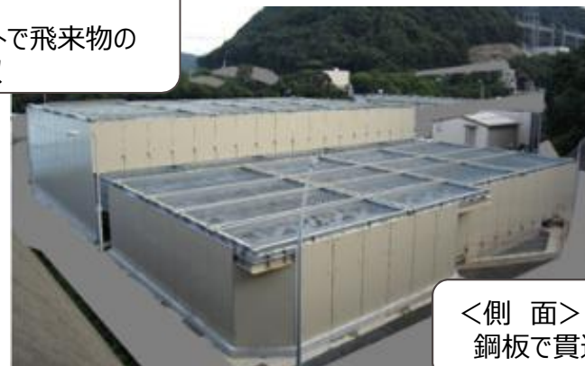
〔竜巻飛来物対策設備設置後〕
