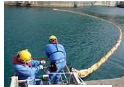
シルトフェンス設置
