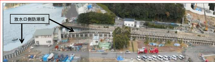
放水口側防潮堤
