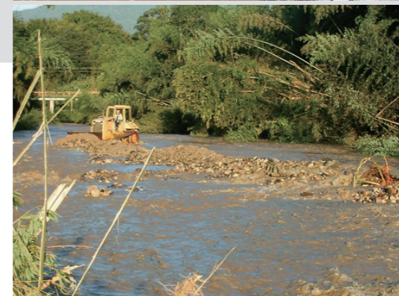
9月17日も早朝から応急工事が行われた
