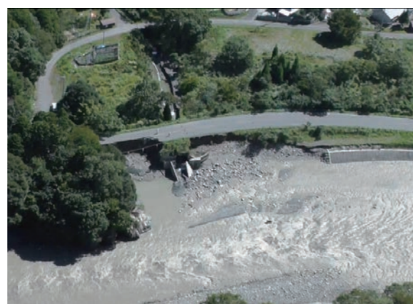
県防災ヘリによる被災状況調査
