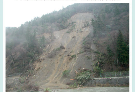
▼平成18年3月に発生した地すべり災害(朽木村井)
