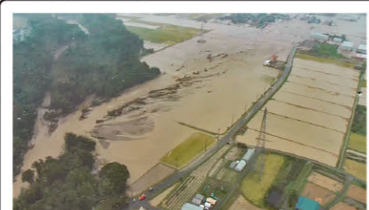
鴨川の決壊 平成25年9月の台風18号で鴨川が決壊し、大きな被害が発生した。
