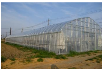
パイプハウス設置状況
