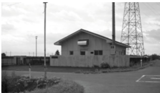
北仰地区 農業集落排水処理施設
