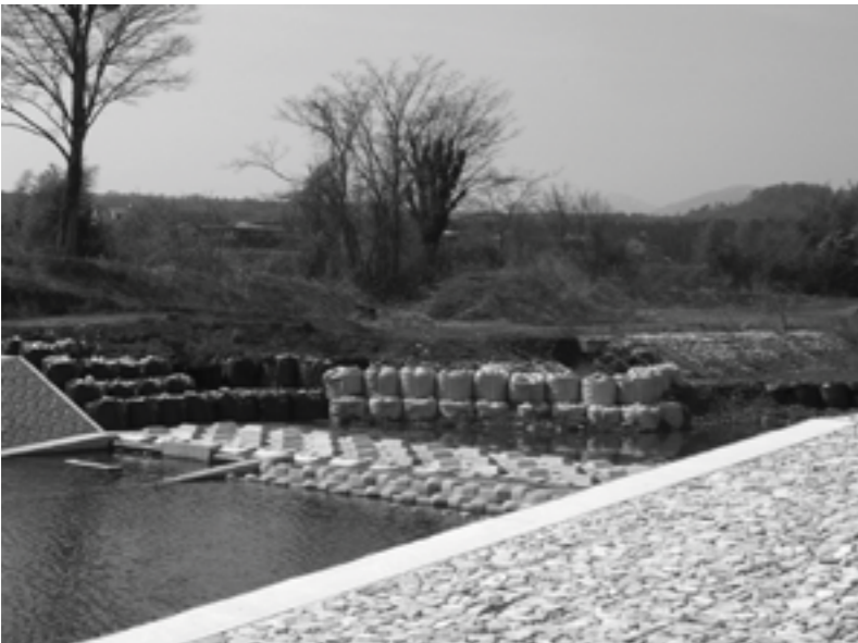
改修が進められる石田川
