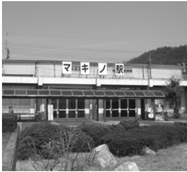
エレベーターの設置が求められるマキノ駅
