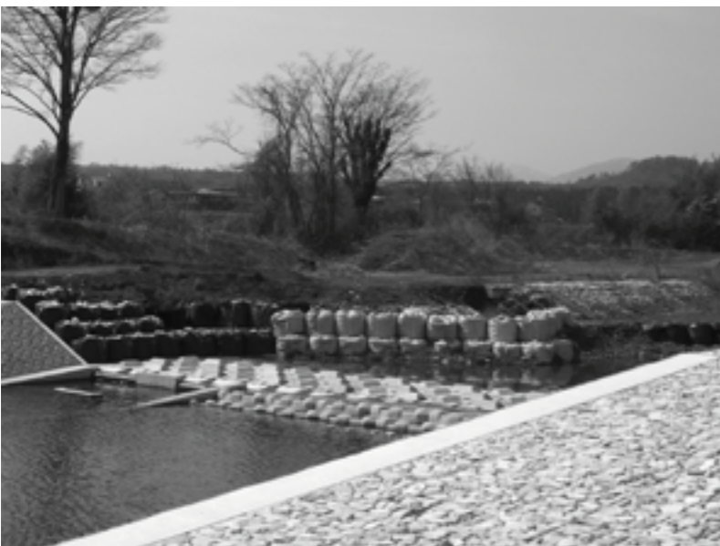
改修が進められる石田川
