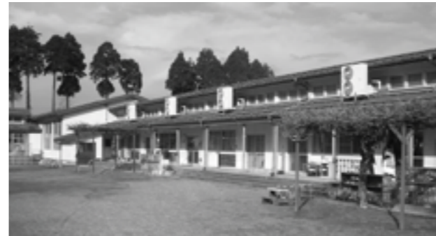
来年度に耐震補強工事が予定される古賀保育園
