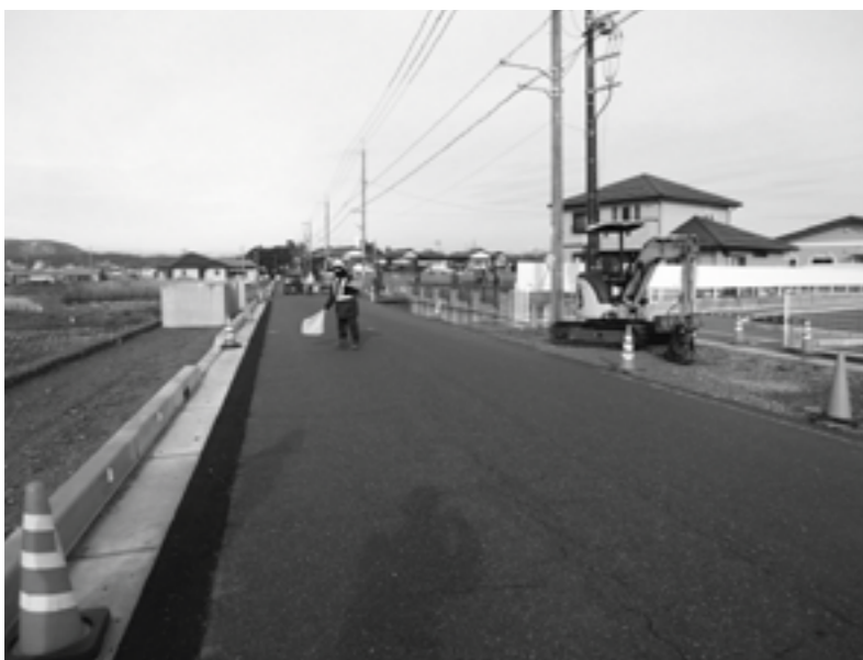
歩道整備等道路改良工事が進む市道青井川線
