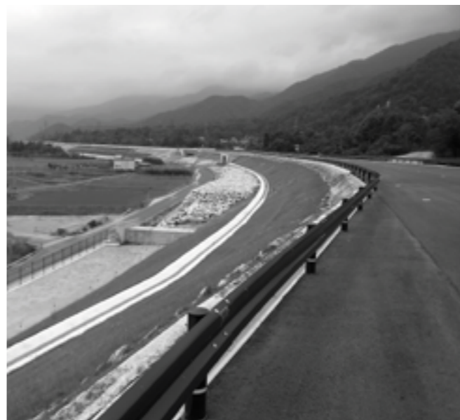
今秋供用開始予定の国道161号志賀バイパス
