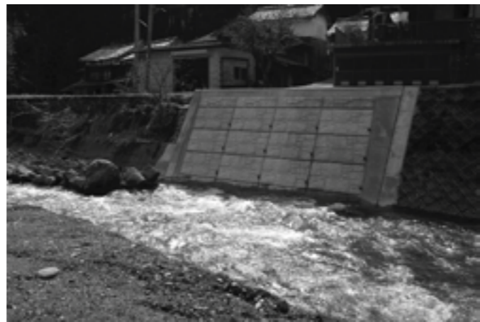
護岸補修工事で河川の維持管理を
