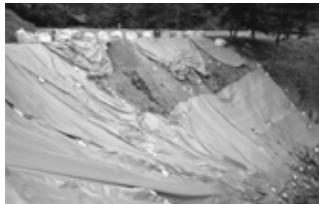
マキノ高原交流広場の災害現場
