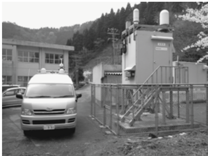
県モニタリングカーと現在は停止しているモニタリングポスト (今津西小学校内)
