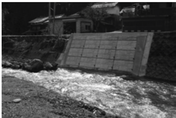
護岸補修工事で河川の維持管理を
