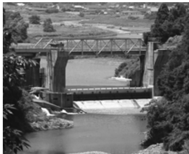
台風で被害が発生した高岩ダム周辺
