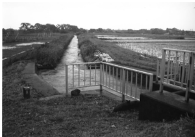
松ノ木内湖に流入する青井川第二樋門施設
