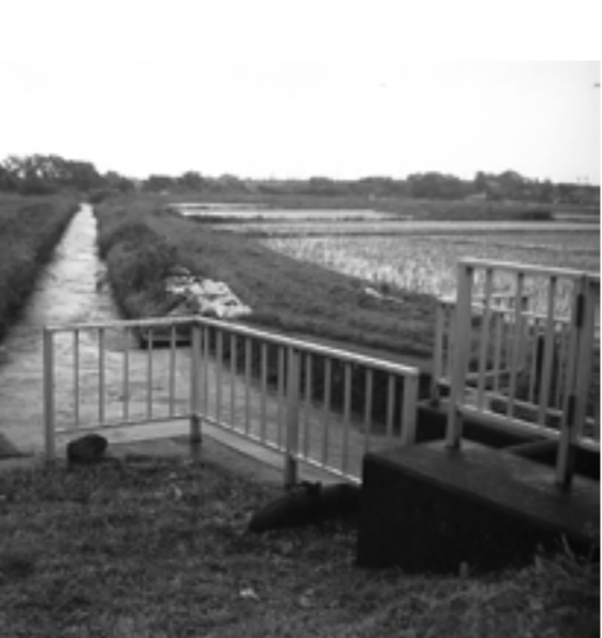
松ノ木内湖に流入する青井川第二樋門施設
