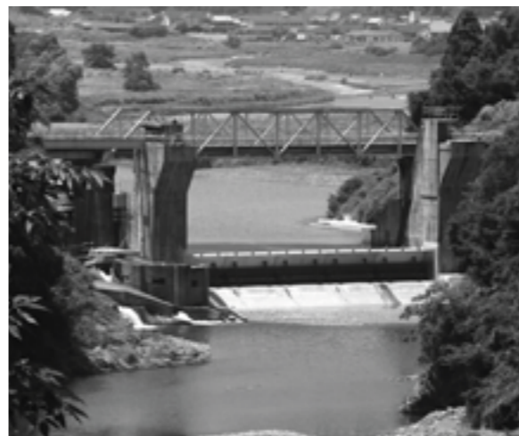
台風で被害が発生した高岩ダム周辺
