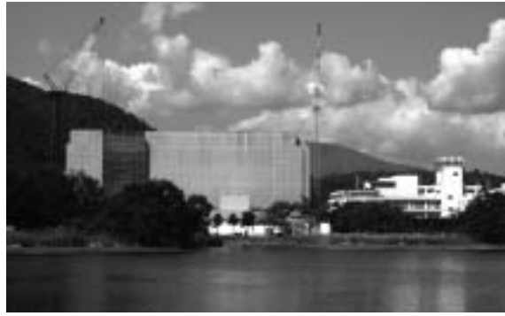
着々と工事が進み、ますます市民の期待が膨らむ市民病院
