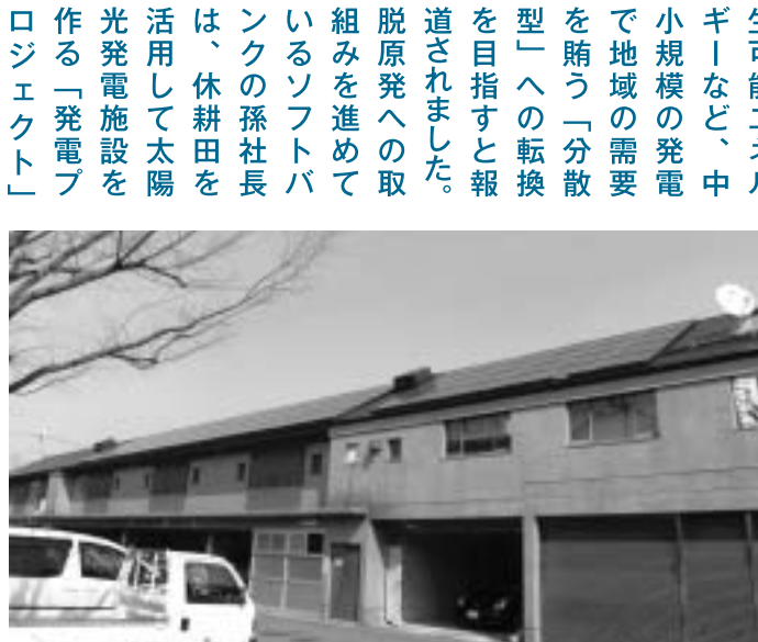
市役所に設置した太陽光発電装置
