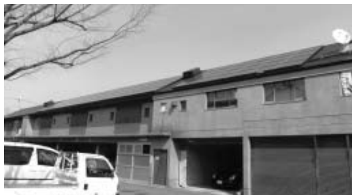
市役所に設置した太陽光発電装置
