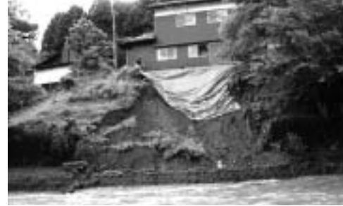
観測史上2番目の雨量での被害
