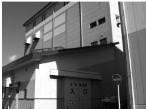
環境に配慮?し建設された「ゴミ焼却施設」
