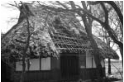
取り壊しされるかやぶき民家
