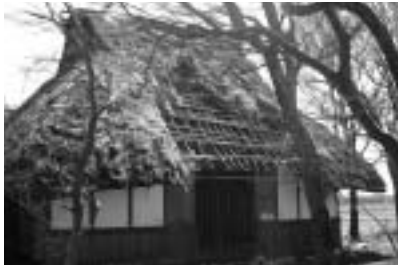
取り壊しされるかやぶき民家
