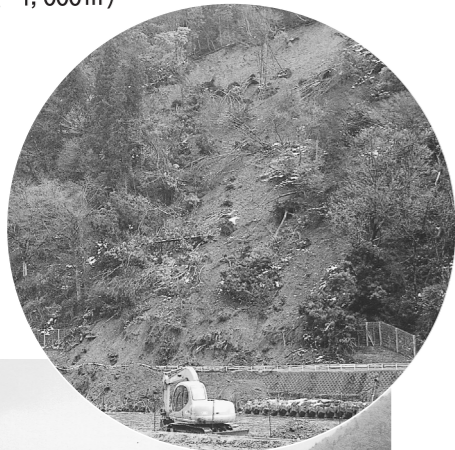
3月8日国道367号での土砂崩れ現場 (村井地先：幅40m、1,000㎡)
