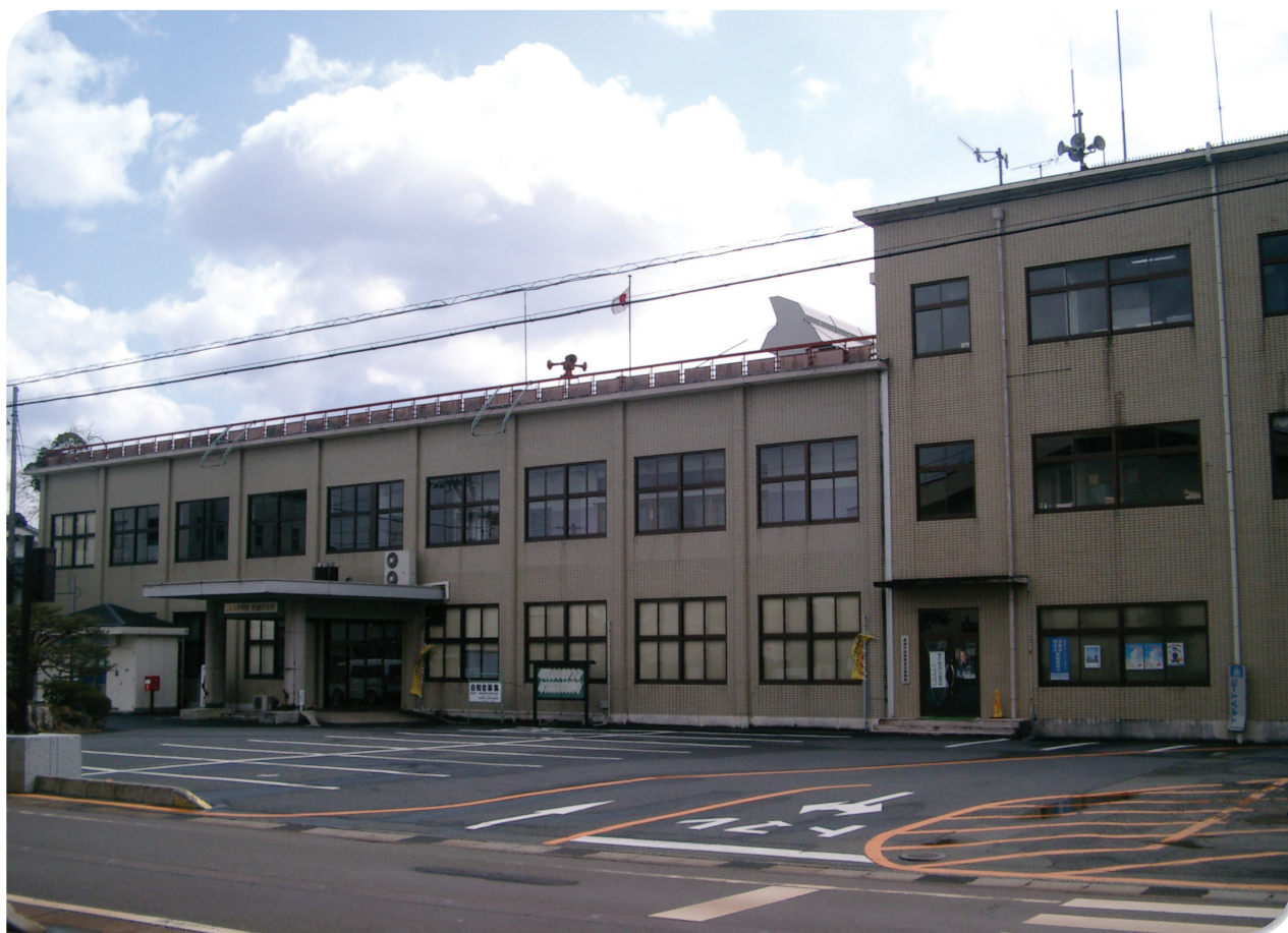
高島市役所 安曇川支所（昭和35年竣工）
