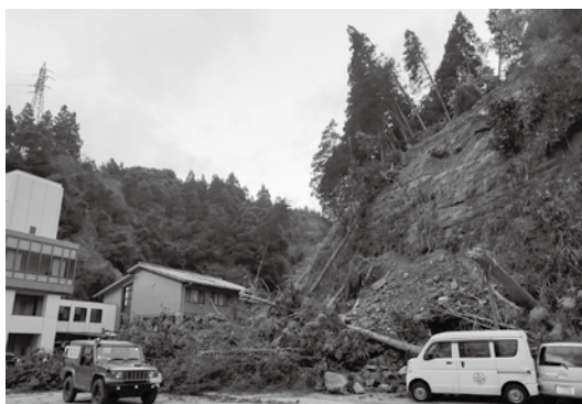
引用：（一財）消防防災科学センター「災害写真データベース」
