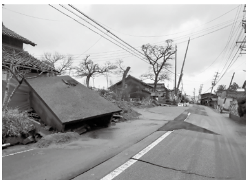
引用：（一財）消防防災科学センター「災害写真データベース」
