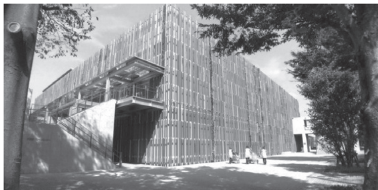
武蔵野クリーンセンター
