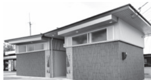
市が設置したマキノ駅のトイレ
