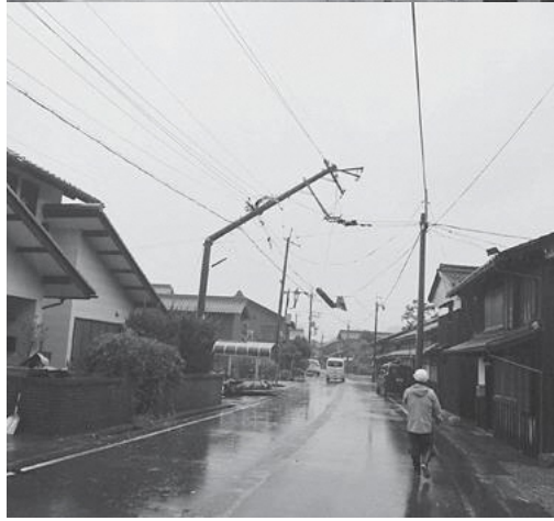
台風 21 号災害・海津地先の様子
