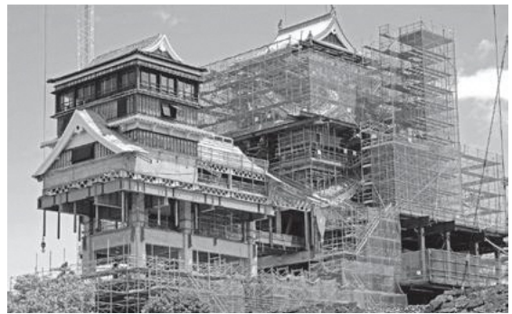
熊本城復旧の様子
