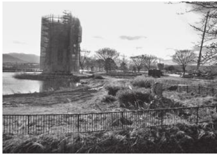
修繕中の風車
