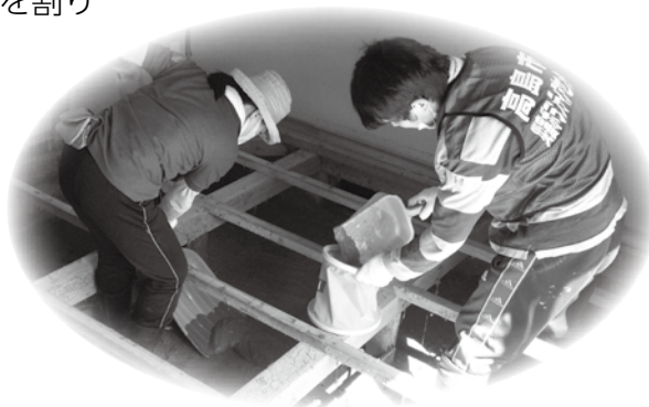
民家の泥出し作業の様子
